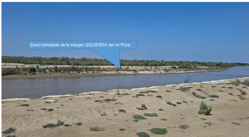
Figura N° 02: Se observa la colmatación en la margen izquierda del cauce del río Piura
